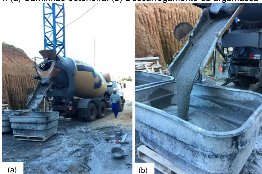
Figura 4: (a) Caminhão betoneira. (b) Descarregamento da argamassa usinada.
