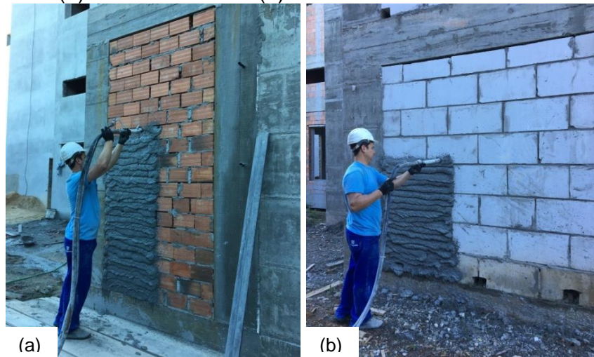
Figura 8: Aplicação da argamassa com projeção mecânica. (a) Bloco cerâmico. (b) Bloco de concreto celular.
