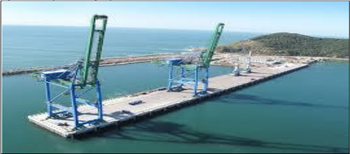
Figura 6 - Berço 1 e 2 ampliação do cais.
