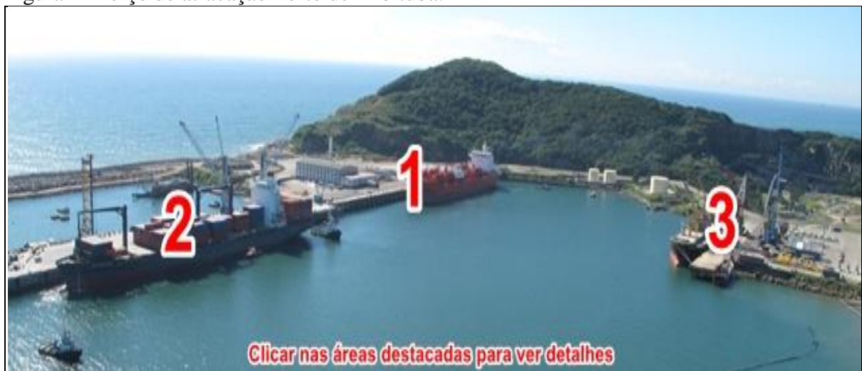
Figura 2- Berço de atracação Porto de Imbituba.
