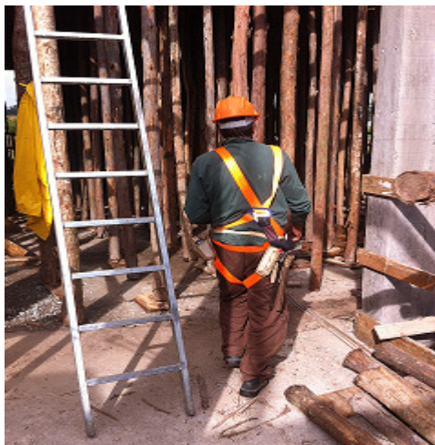
Figura 5 – Trabalho em Altura Obra 01
