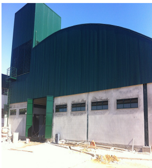
Figura 2 – Fase atual da obra 02
