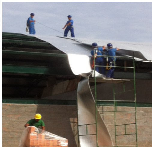
Figura 6 – Trabalho em Altura Obra 02
