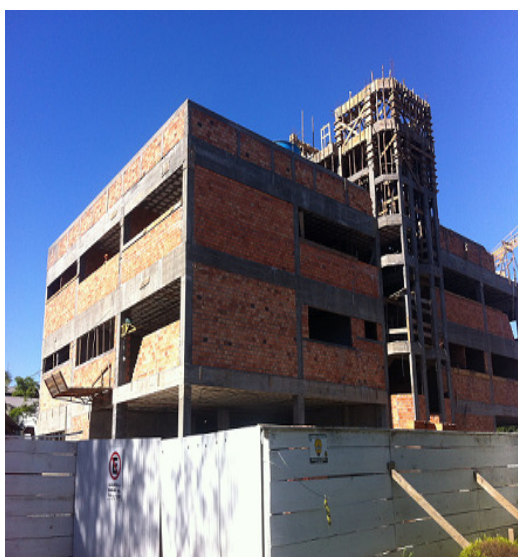
Figura 1 – Fase atual da obra 01
