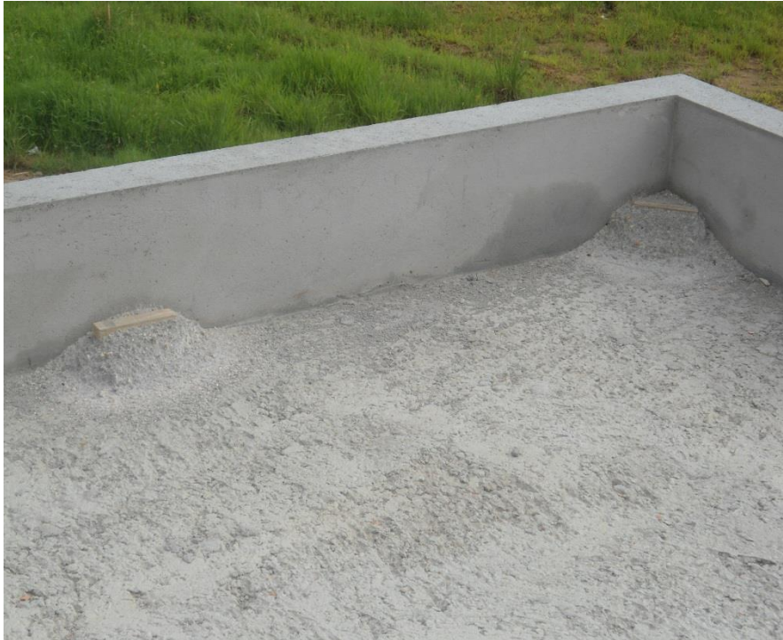
figura 1 - Colocação dos tacos para regularização do enchimento.
