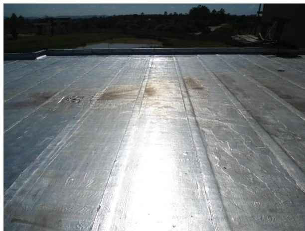
Figura 9 - Novo teste de estanqueidade após reparos na impermeabilização.
