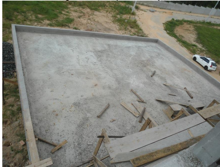
Figura 3 - Limpeza da laje.
