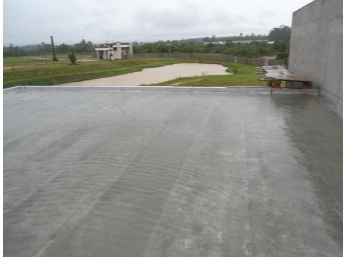
Figura 7 - Teste de estanqueidade
