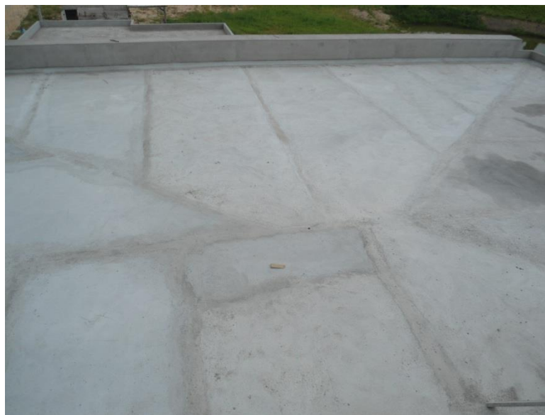
Figura 2 - regularização do enchimento.
