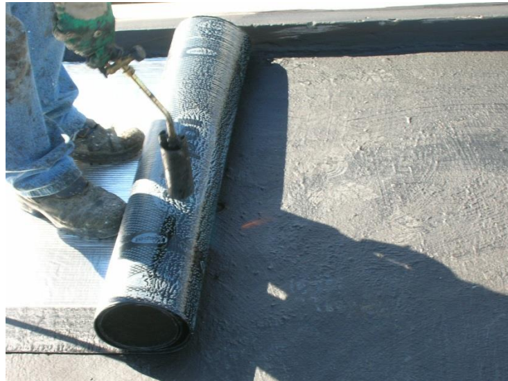
Figura 5 - Colocação da manta asfáltica revestida com filme de alumínio.
