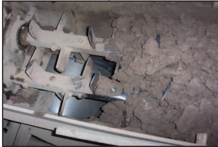
Figura 5 - Vista parcial do homogeneizador, Morro da Fumaça/SC.
