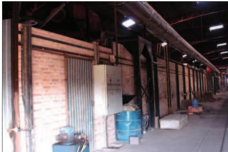
Figura 15 - Vista lateral de forno contínuo em cerâmica, Morro da Fumaça/SC.
