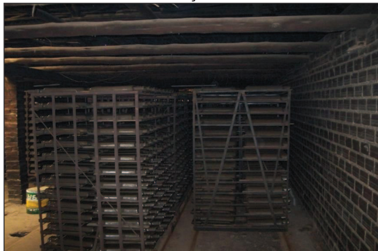
Figura 12 - Vista frontal de estufa para a secagem de peças cerâmicas, Morro da Fumaça/SC.
