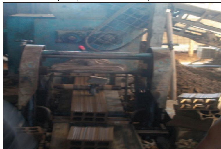
Figura 8 - Vista frontal do conjunto maromba e cortador destinado à produção de tijolos, Morro da Fumaça/SC.
