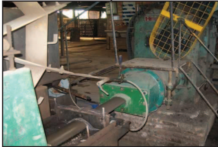
Figura 7 - Vista frontal da “maromba” destinada à produção de telhas, Morro da Fumaça/SC.
