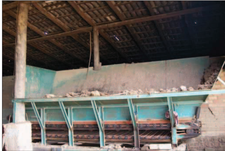
Figura 3 - Silo de alimentação de argila, chamado de "caixão alimentador", Morro da Fumaça/SC.
