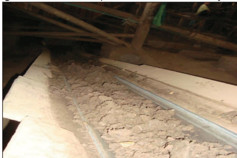
Figura 4 - Correia transportadora, Morro da Fumaça/SC.
