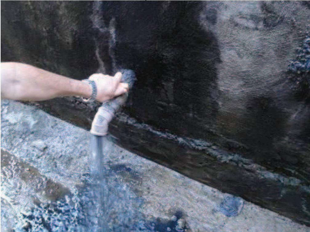
Figura 14: Saída dos efluentes dos tanques.
