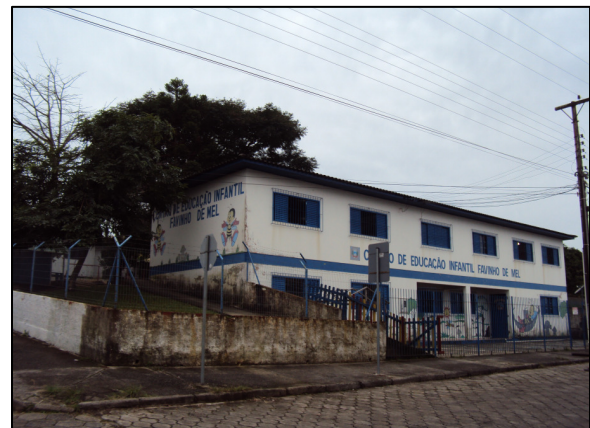
Figura 8 – Fachada creche Favinho de Mel
